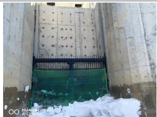
进水闸及拦鱼网
