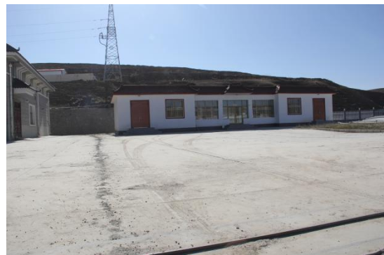
2#泵站厂区硬化
