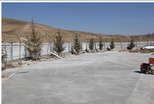
3#泵站厂区硬化及绿化
