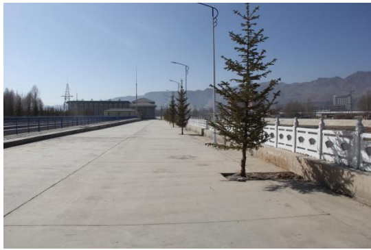
1#泵站厂区硬化及绿化
