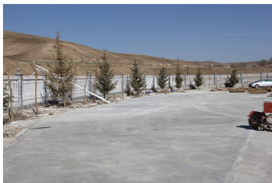
3#泵站厂区硬化及绿化
