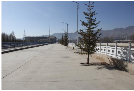
1#泵站厂区硬化及绿化
