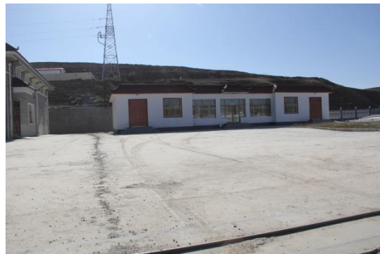
2#泵站厂区硬化
