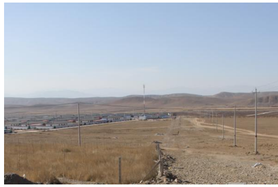
供水管线植被恢复状况
