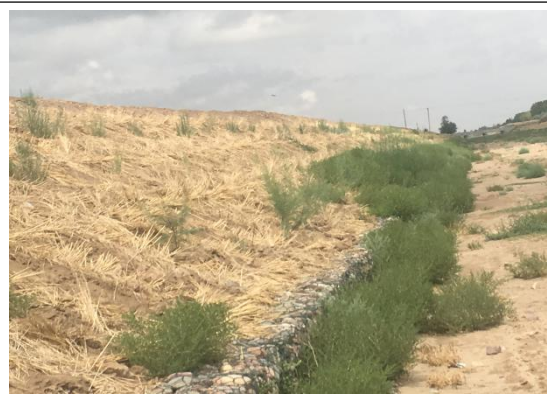
河道内坡植被恢复状况
