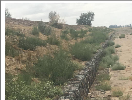
河道内坡植被恢复状况
