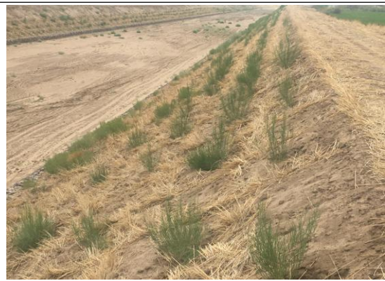
河道内坡植被恢复状况
