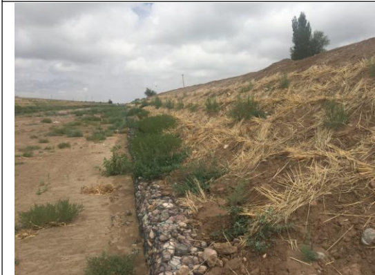
河道内坡植被恢复状况
