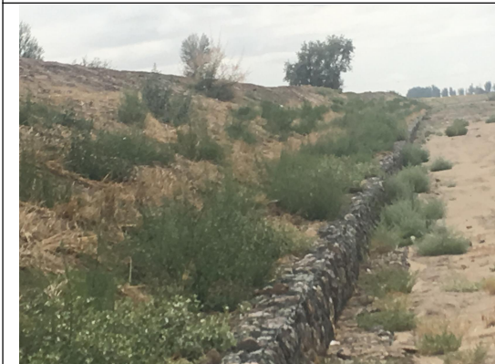
河道内坡植被恢复状况
