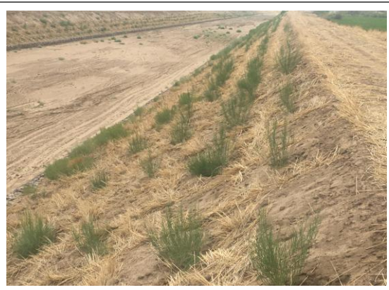
河道内坡植被恢复状况
