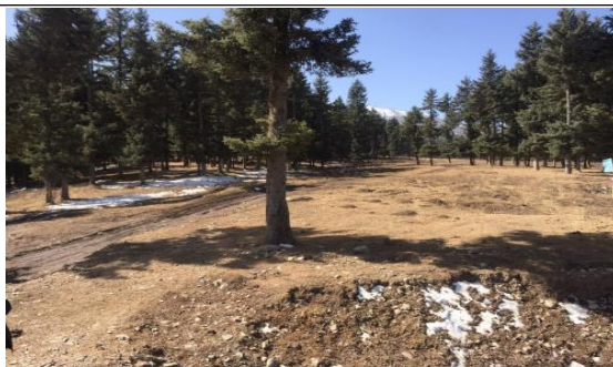
水泉村供水管网恢复
