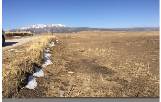
水泉村供水管网地表恢复
