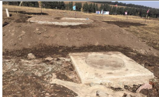
水泉掌村供水控制井
