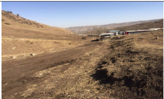
水泉村上沟输水管网恢复
