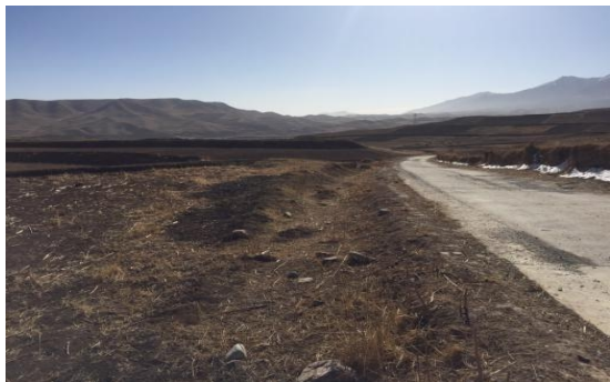
水泉村供水管网地表恢复
