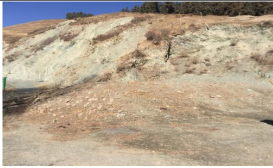
尖山村工程 50m 3 蓄水池
