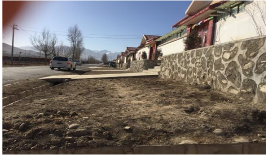
古城村供水管网入户
