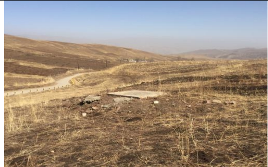
水泉村东沟供水控制井
