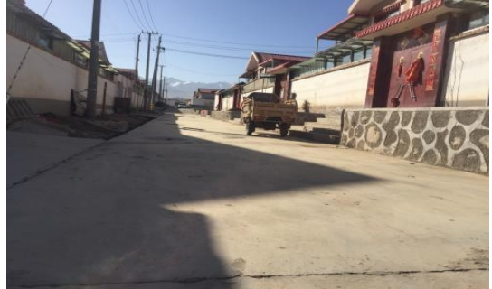
古城村供水管网入户
