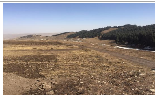
水泉掌村输水管网恢复
