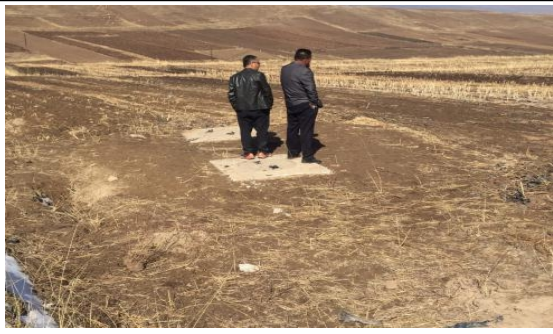
水泉村东沟 50m 3 蓄水池
