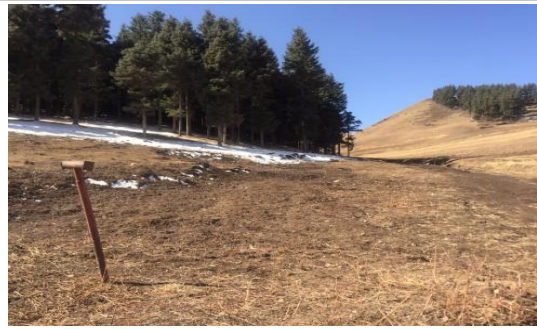
水泉村上沟供水管网恢复
