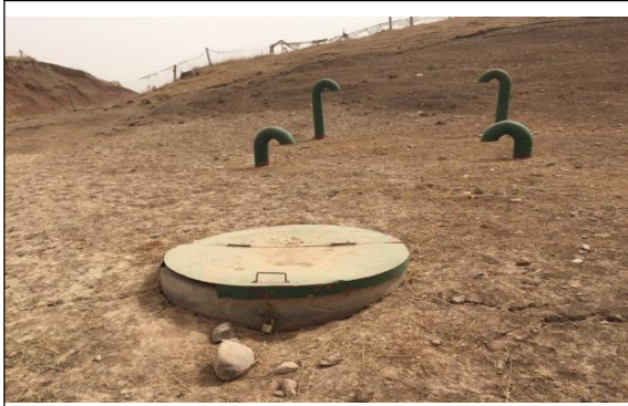
上泉村 500m 3 蓄水池
