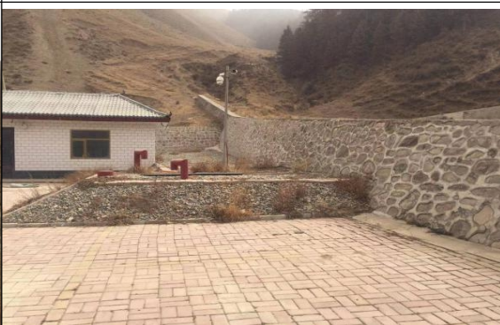
西大滩马场村水厂蓄水池
