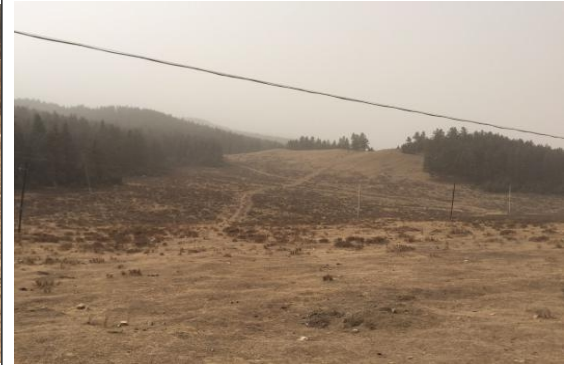
土星村输水管网地表恢复
