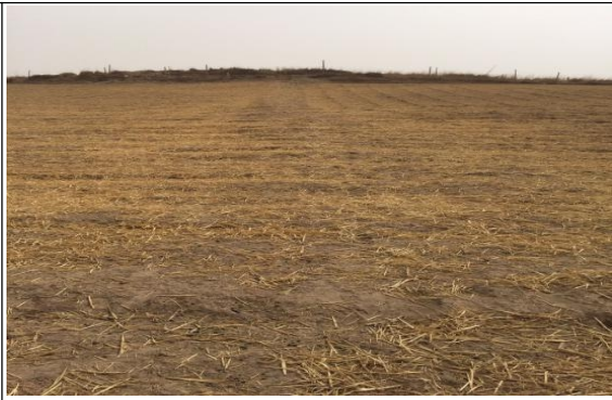
上泉村输水管网地表恢复
