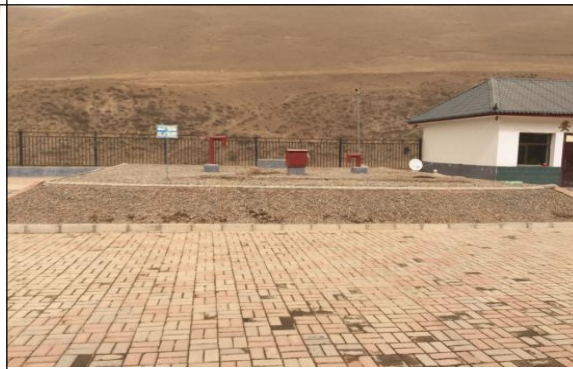
安远水厂 50m 3 蓄水池
