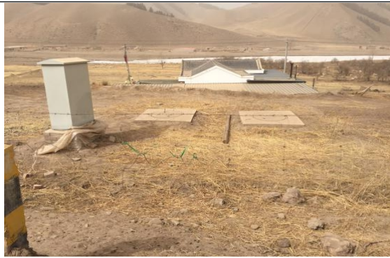
上泉村 50m 3 蓄水池
