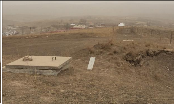
马场村输水管网地表恢复
