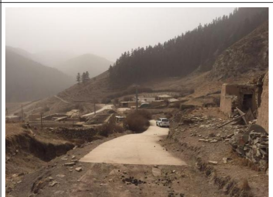
西沟上罗圈湾输水管道地表恢复
