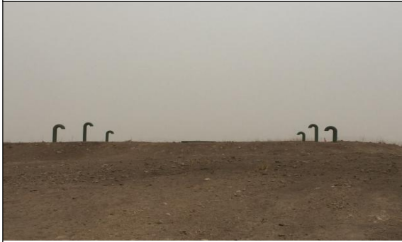
马场村 2000m 3 蓄水池
