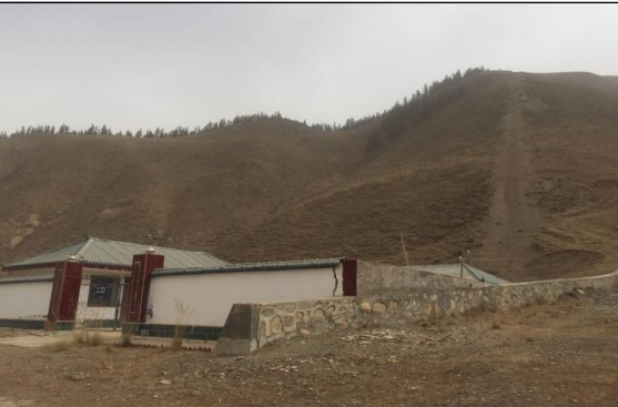
马场净水厂输水管道地表恢复
