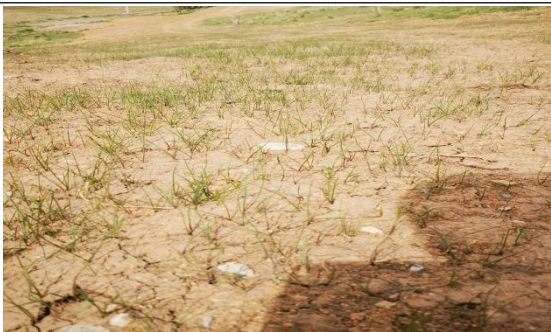
赛什斯供水管网地表恢复
