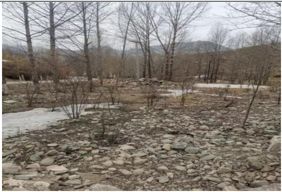
天堂镇输水管网地表恢复
