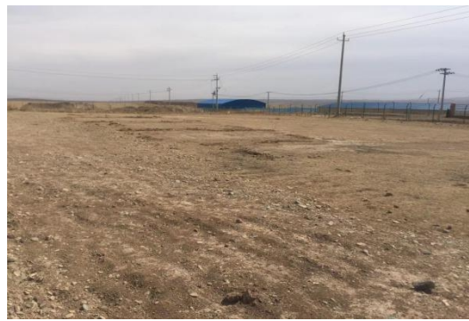
松山水管所南阳水厂施工料场恢复
