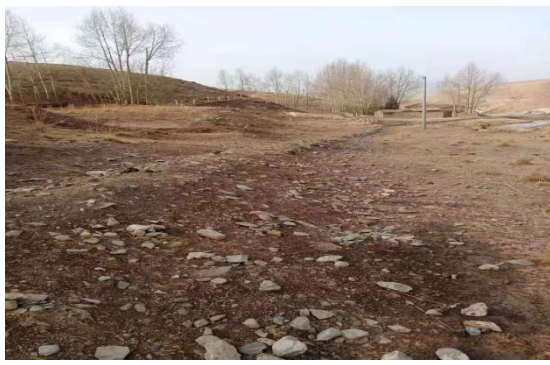
炭山岭输水管网地表恢复
