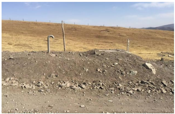
红疙瘩村新建蓄水池
