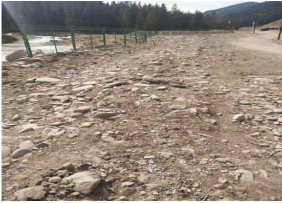
东大滩乡输水管网地表恢复
