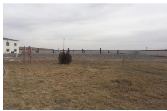
松山水管所南阳水厂生态恢复
