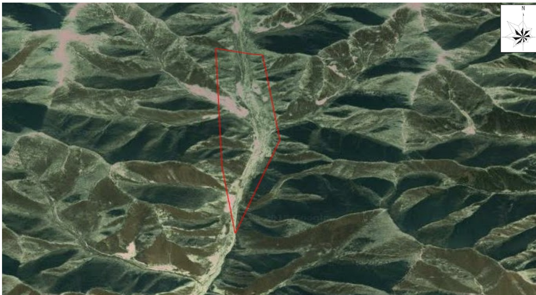
天祝县天堂镇集镇农村饮水安全“冲刺清零” 工程项目
