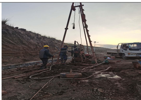
地下水井建设
