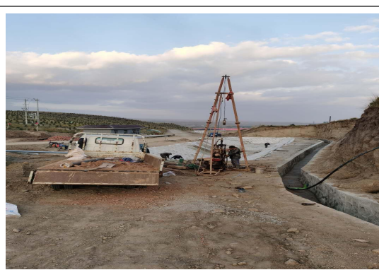
地下水井建设
