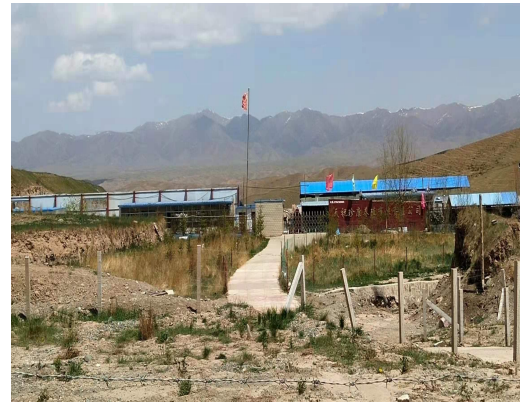
南山村施工营地
