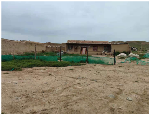
松山灌区施工营地
