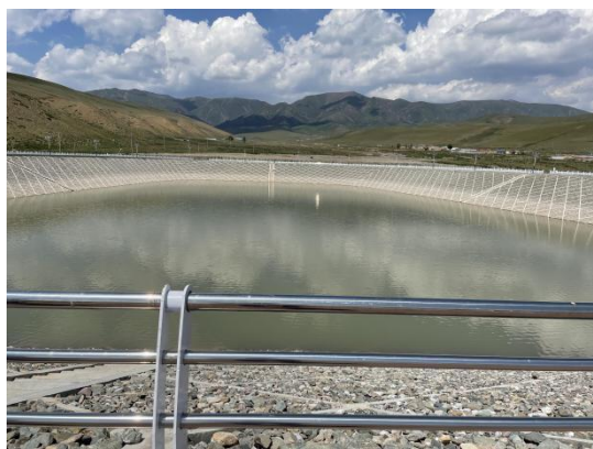
黄草川调蓄水池
