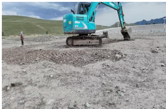
黄草川施工场地覆土、植被恢复中
