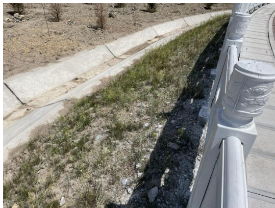
黄草川调蓄水池外坝坡植被恢复状况
