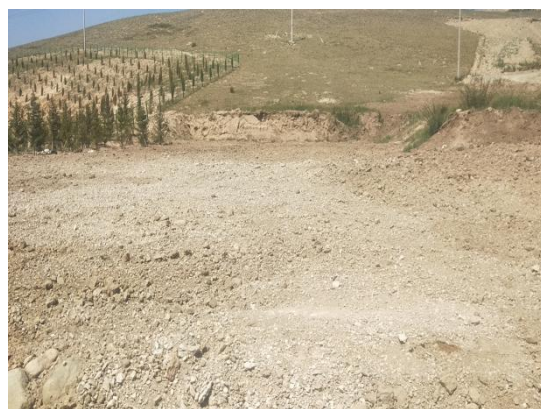
柏林沟砂石料场覆土、植被恢复中
