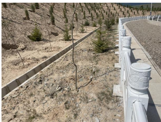
柏林沟调蓄水池截排水沟
