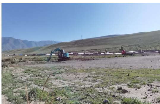
黄草川砂石料场覆土、植被恢复中
