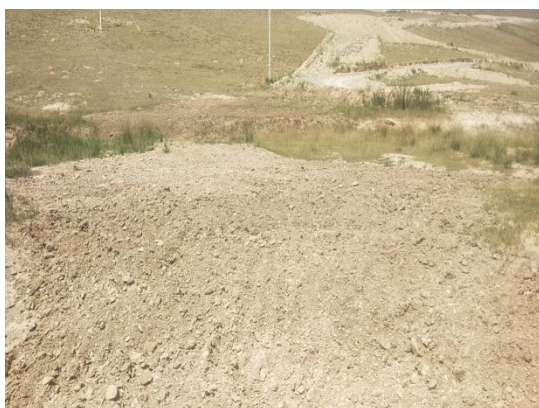
柏林沟施工场地覆土、植被恢复中
