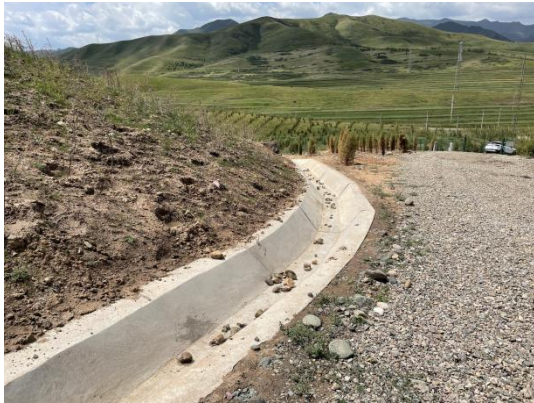
大湾调蓄水池截排水沟
