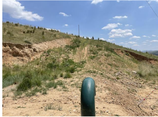
一千管管线植被恢复状况
