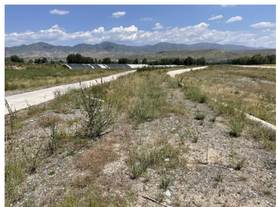
二千管管线植被恢复状况
