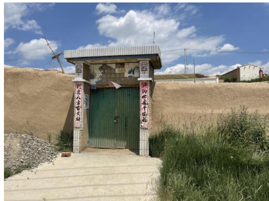
一千管施工营地租用上河东村村庄房屋
