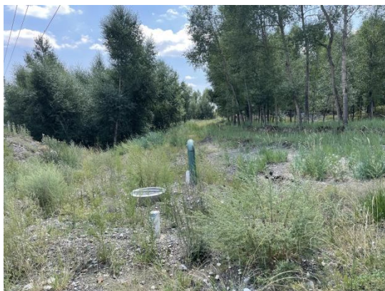
二千管管线植被恢复状况
