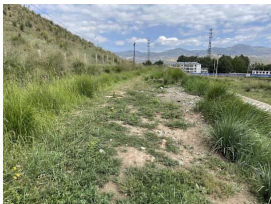
二千管管线植被恢复状况
