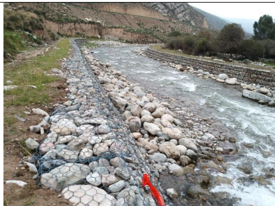
冰沟河河堤概貌
