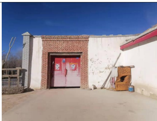
祁连村施工营地
