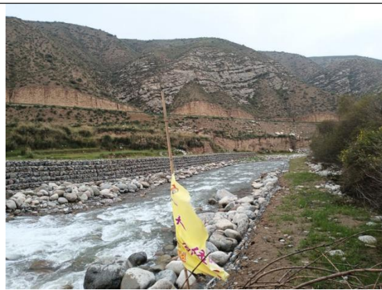
冰沟河河堤概貌
