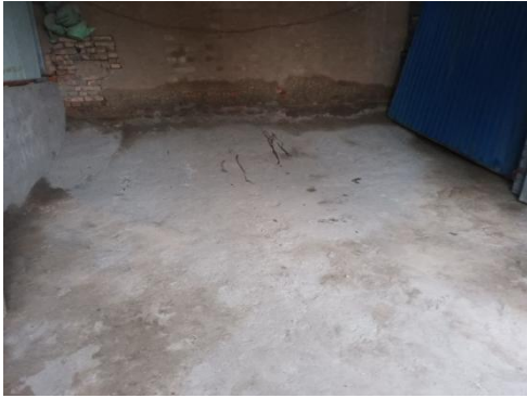
一般固废暂存间
