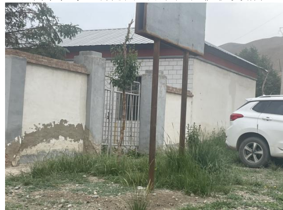
石门镇火烧城村施工营地租用附近房屋
