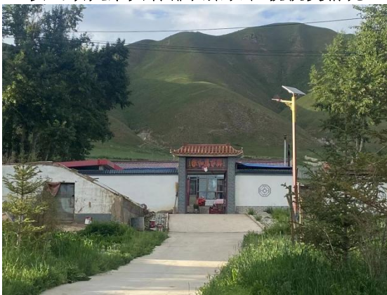
安远镇大泉头村施工营地租用附近房屋
