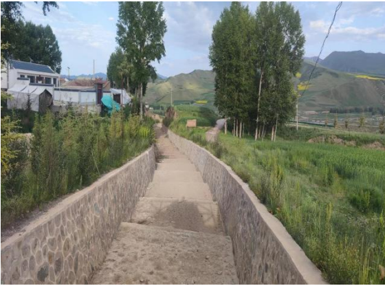
安远镇大泉头村排洪渠及植被恢复情况
