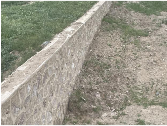
石门镇火烧城村排洪渠
