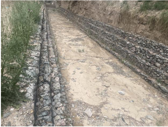
打柴沟安家河村格宾石笼衬砌梯形排洪渠
