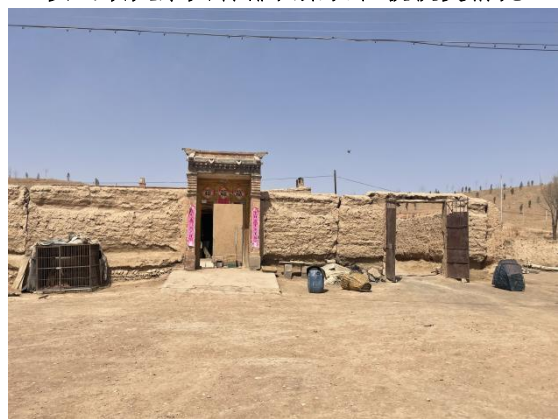
鞍子山施工营地租用附近房屋
