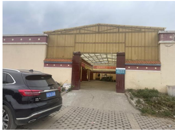
石门镇石板湾村和宽沟村施工营地租用附近房屋
