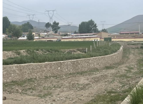
石门镇火烧城村防洪堤渠及植被恢复情况
