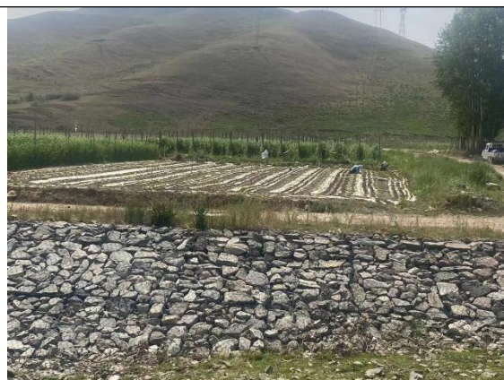
打柴沟段防洪堤
