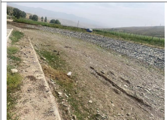
打柴沟段防洪堤
