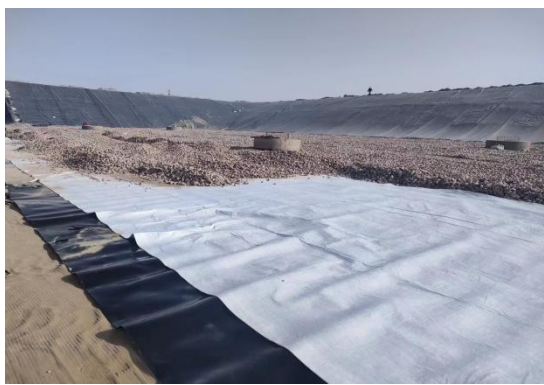
二期填埋场铺防渗层
