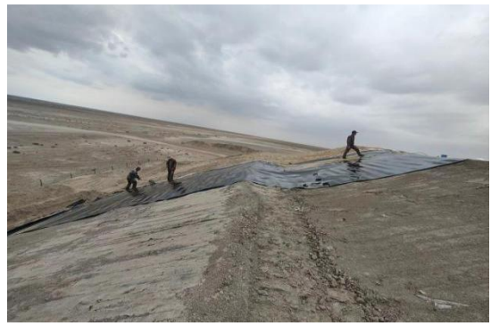
一期封场前铺防渗
