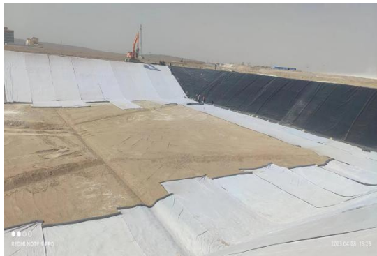
二期填埋场铺防渗层
