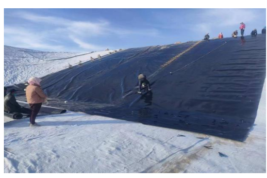
二期填埋场铺防渗层
