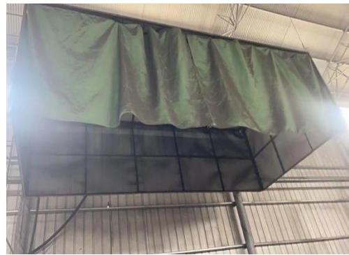
破碎工段集气罩
