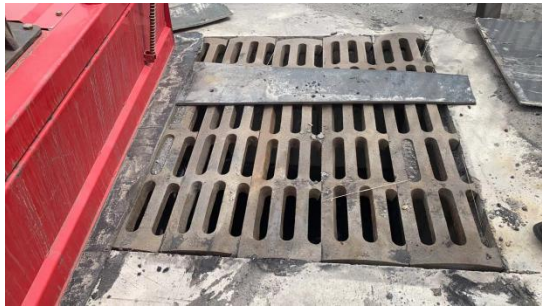
初期雨水收集池
