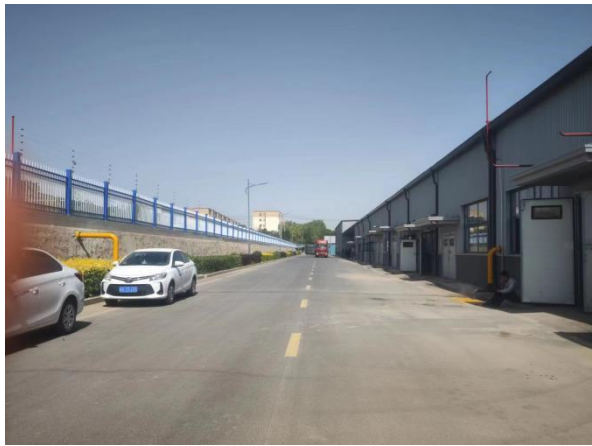
天然气管道施工后地面恢复
