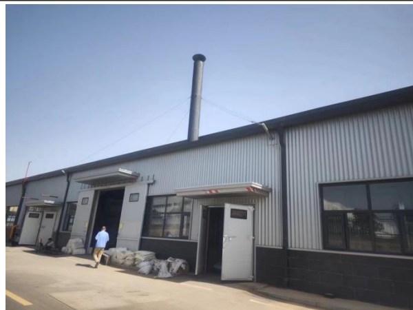
天然气锅炉烟囱
