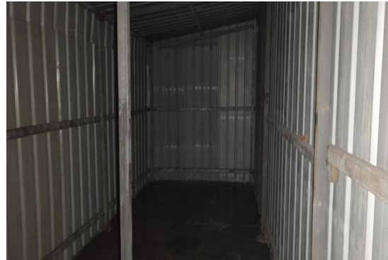
危废暂存间防渗情况
