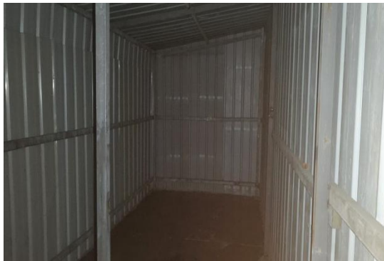
危废暂存间防渗情况
