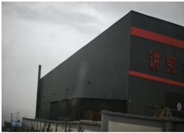
二号线排气筒 (DA004)
