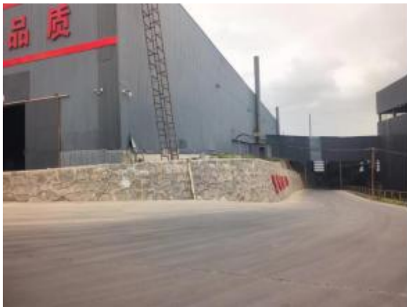
一级品加工生产线旋风+布袋除尘+排气筒(DA002、DA003)
