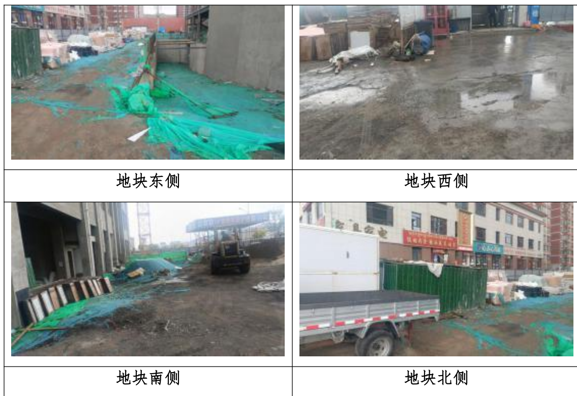
图3-6 地块现状照片
