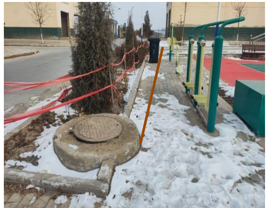
污水管网地面恢复
