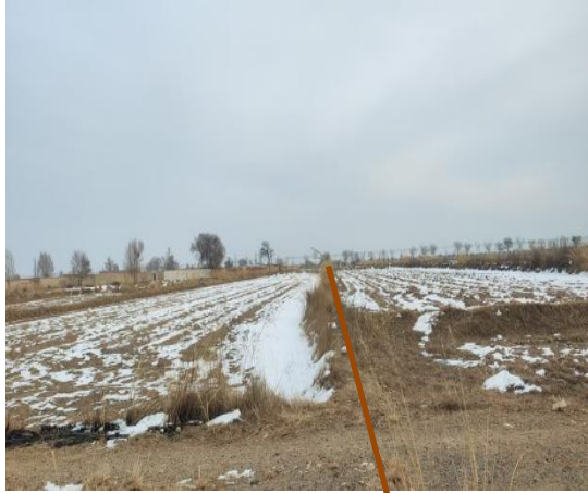
污水管网地面恢复
