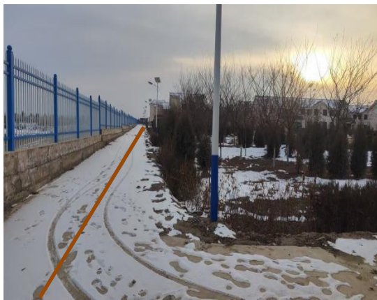
污水管网地面恢复
