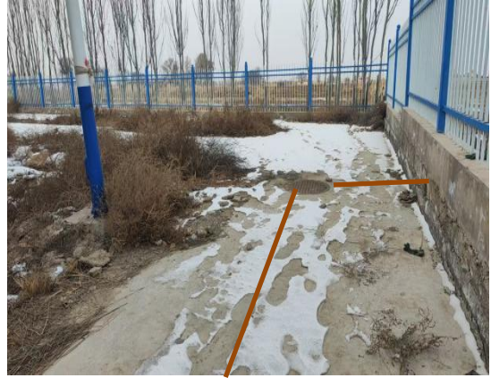
污水管网地面恢复
