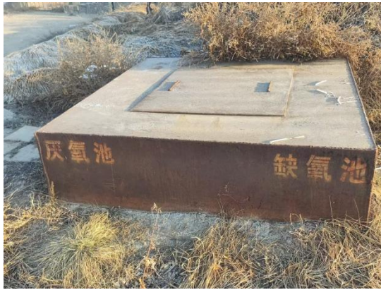
厌氧池、缺氧池
