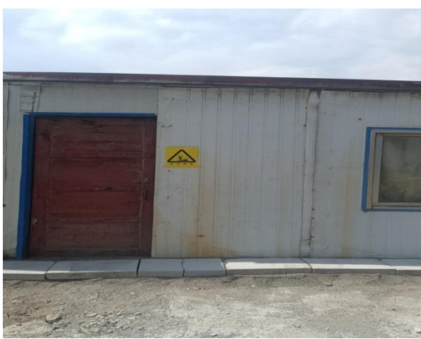
危险废物贮存库
