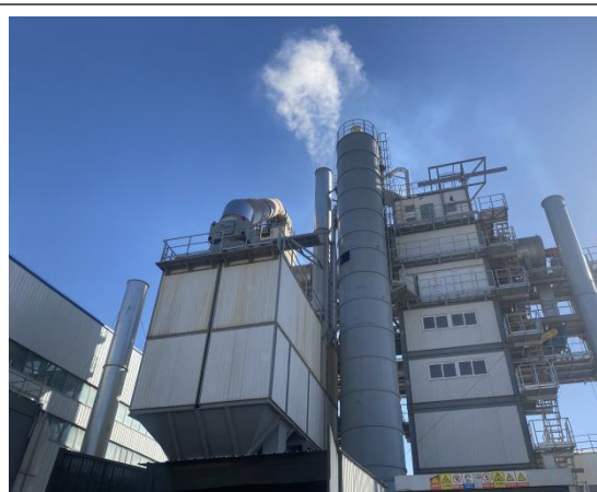
烘干工段排气筒
