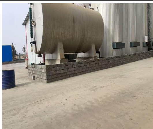
柴油储罐围堰
