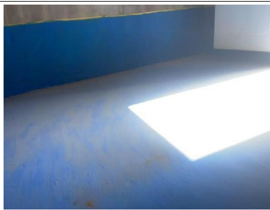
危废暂存间内部
