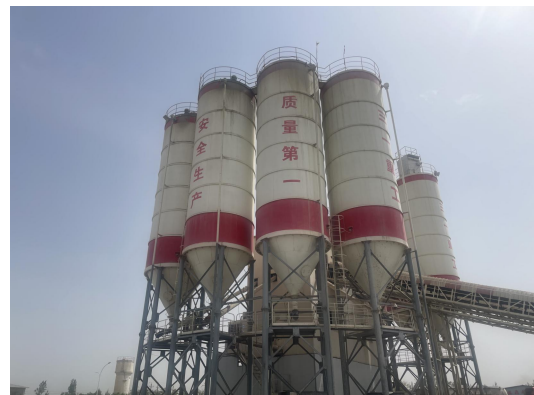
2个粉煤灰、2个水泥筒仓及无动力滤芯除尘器
