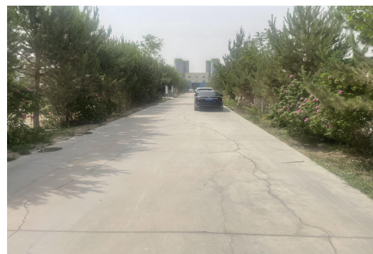
地面硬化及厂区绿化
