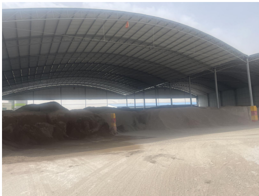
半封闭式砂石料堆场
